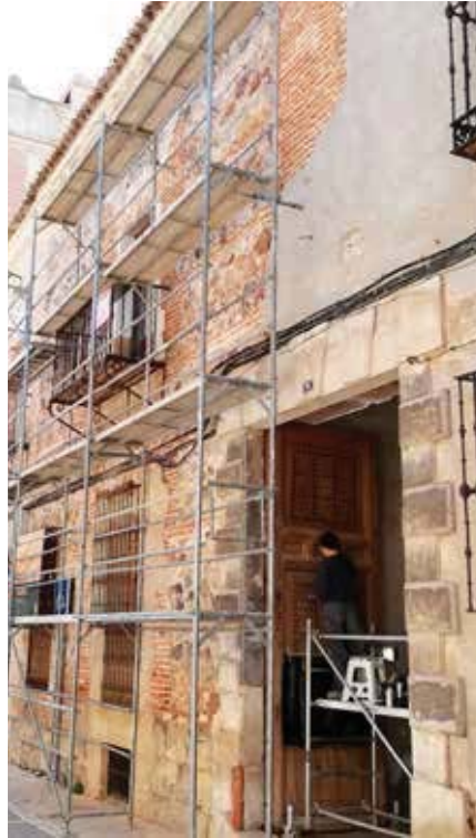
Figura 01: Fachada del nº 3 de calle Collados durante el montaje del andamio para su restauración.
