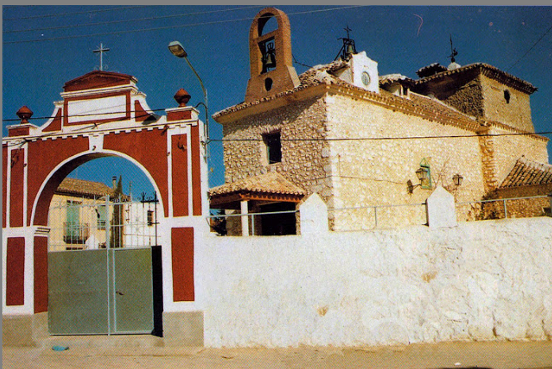
Figura 13. Fotografía de la ermita en los años 80. Puede observarse la incorporación del nuevo atrio sobre la portada y la fábrica de mampostería que integra los muros de la construcción, despojada del revestimiento que había venido protegiéndola desde su origen. ROJO GARCÍA-LAJARA, Rufino. Historia de la muy noble y leal villa de Corral de Almaguer , pág. 177. Madrid. 1991.
