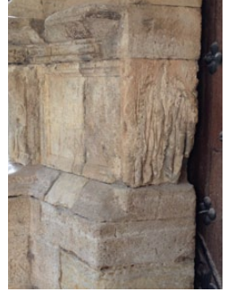
Pérdidas de material original oculo tras un mortero de cemento
