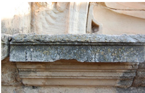
Detalle del estado inicial
