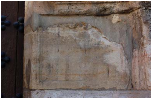
Detalle del estado inicial
