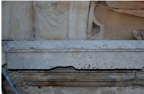
Fragmento de cornisa durante la restauración
