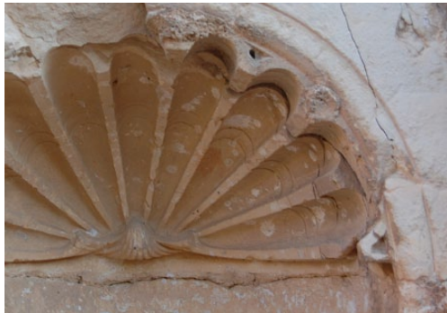
Detalle del estado inicial
