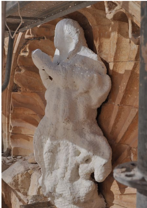
Eliminación de sales solubles mediante papetas
