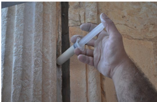
Inyección de mortero de cal para cerrar la rotura existente
