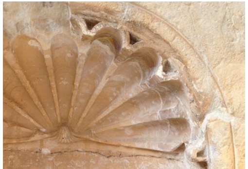
Detalle de la consolidació estructural
