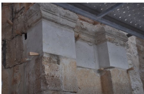
Bloques de nueva fábrica
