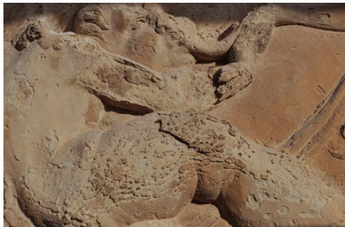
Desaparición de la epidermis original del material pétreo
