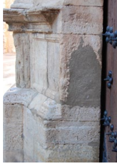
Pérdidas de material original oculo tras un mortero de cemento
